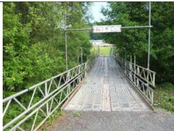
Foto 3: Behelfsbrücke über die Weil (im Hintergrund Kläranlage)
