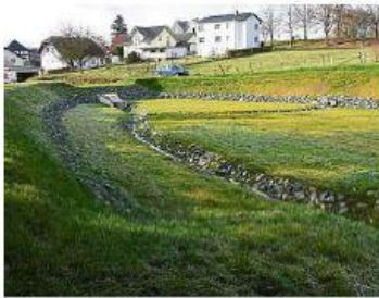
Hochwasserschutz in Edelsberg: Das Rückhaltebecken ist bereit für eine eventuelle Überschwemmung. Foto: Margit Bach
